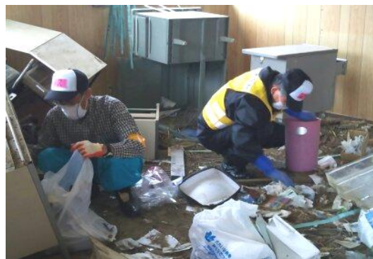
【倉庫内の清掃】
